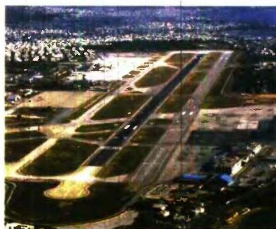
Οι εγκαταστάσεις στο παλιό αεροδρόμιο του Ελληνικού.
